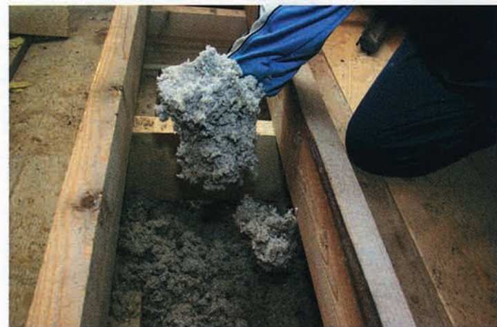
SELLUVILLA on Ekovillan valmistamaa, puhaltamalla käsiteltävää paperirouhetta. Lattiassa eristekerros on 425 mm paksu.
