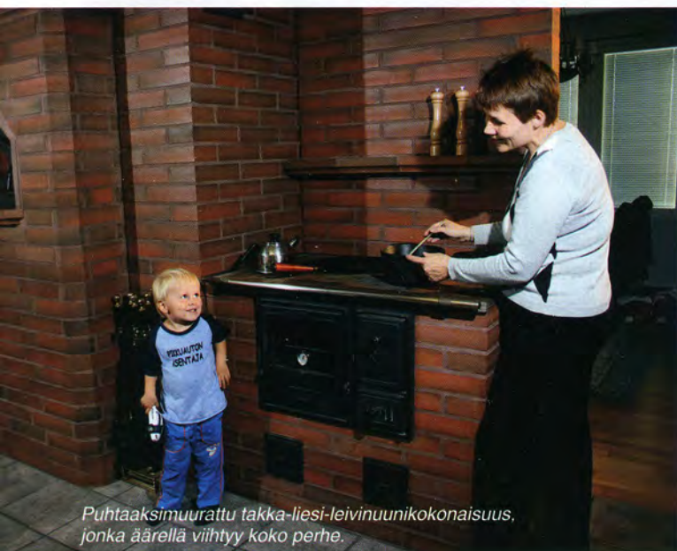
Punatiilestä puhtaaksimuurattu takka-hella-leivinuuni olohuoneen puolelta. Muuraaja Muurarimestari Taisto Kosonen.
